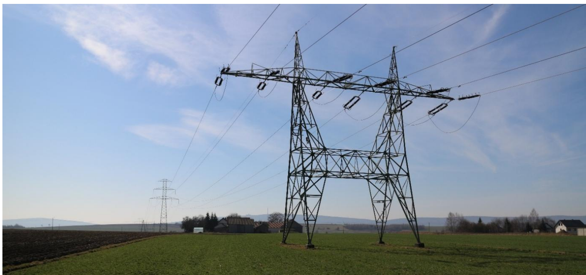
Fot. 2 Linia elektroenergetyczna wysokiego napięcia (widok w kierunku południowo zachodnim)
